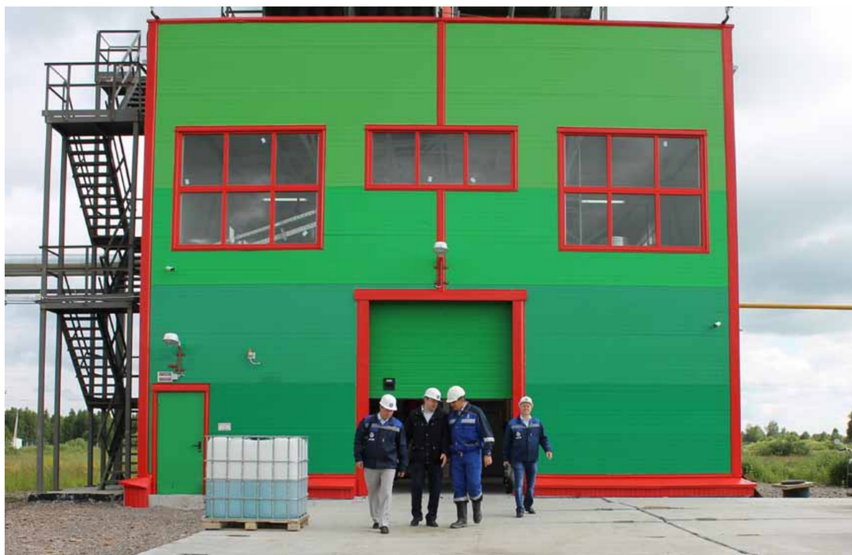
Здание установки когенерации
